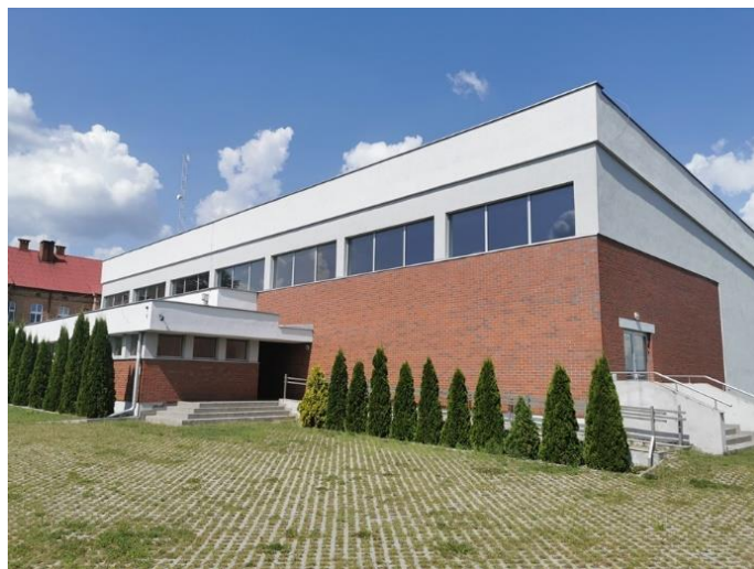
Zdjęcie 4. Sala sportowa przy Szkole podstawowej w Wielkim Komorsku
